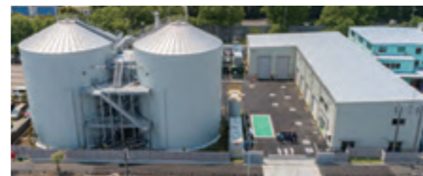
西東京リサイクルセンター
